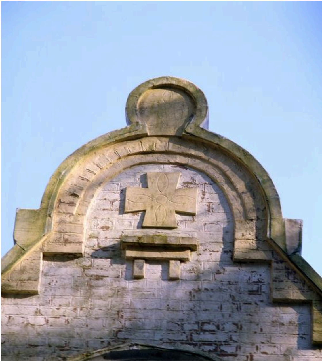
Détail d'un fronton-pignon en façade.
