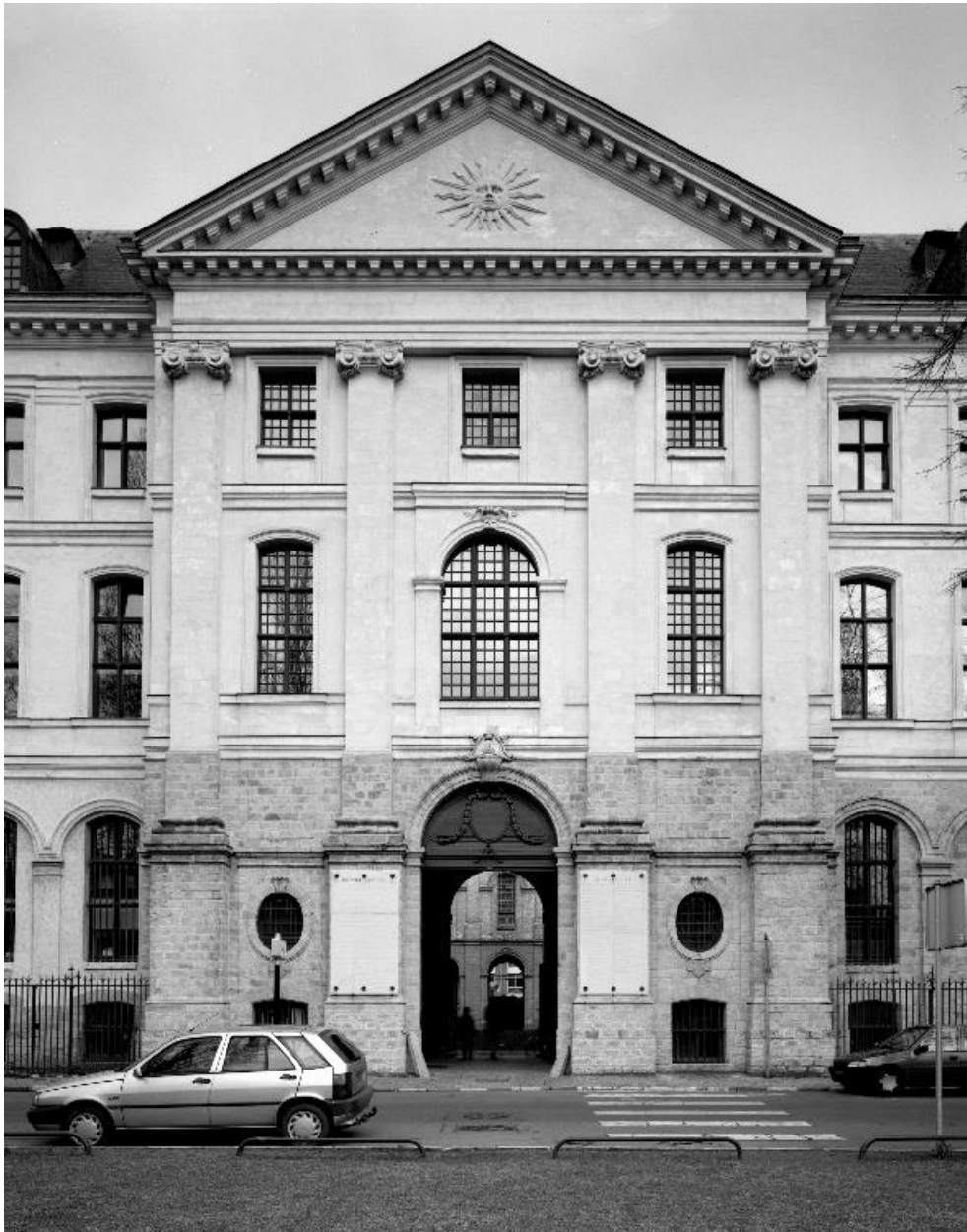
Bâtiment principal, élévation donnant sur l'avenue du Peuple-Belge, détail de l'avant-corps central.
