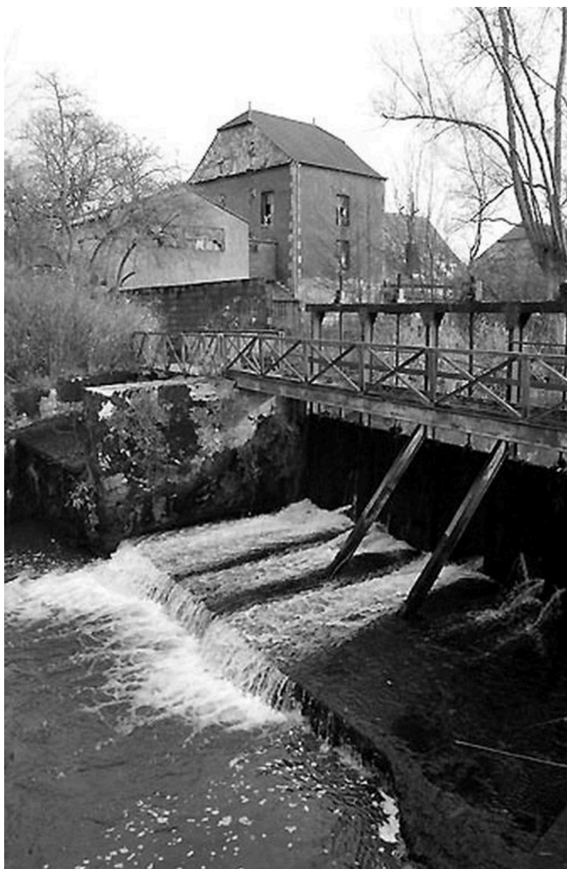
Vue des bâtiments du moulin et du barrage.
