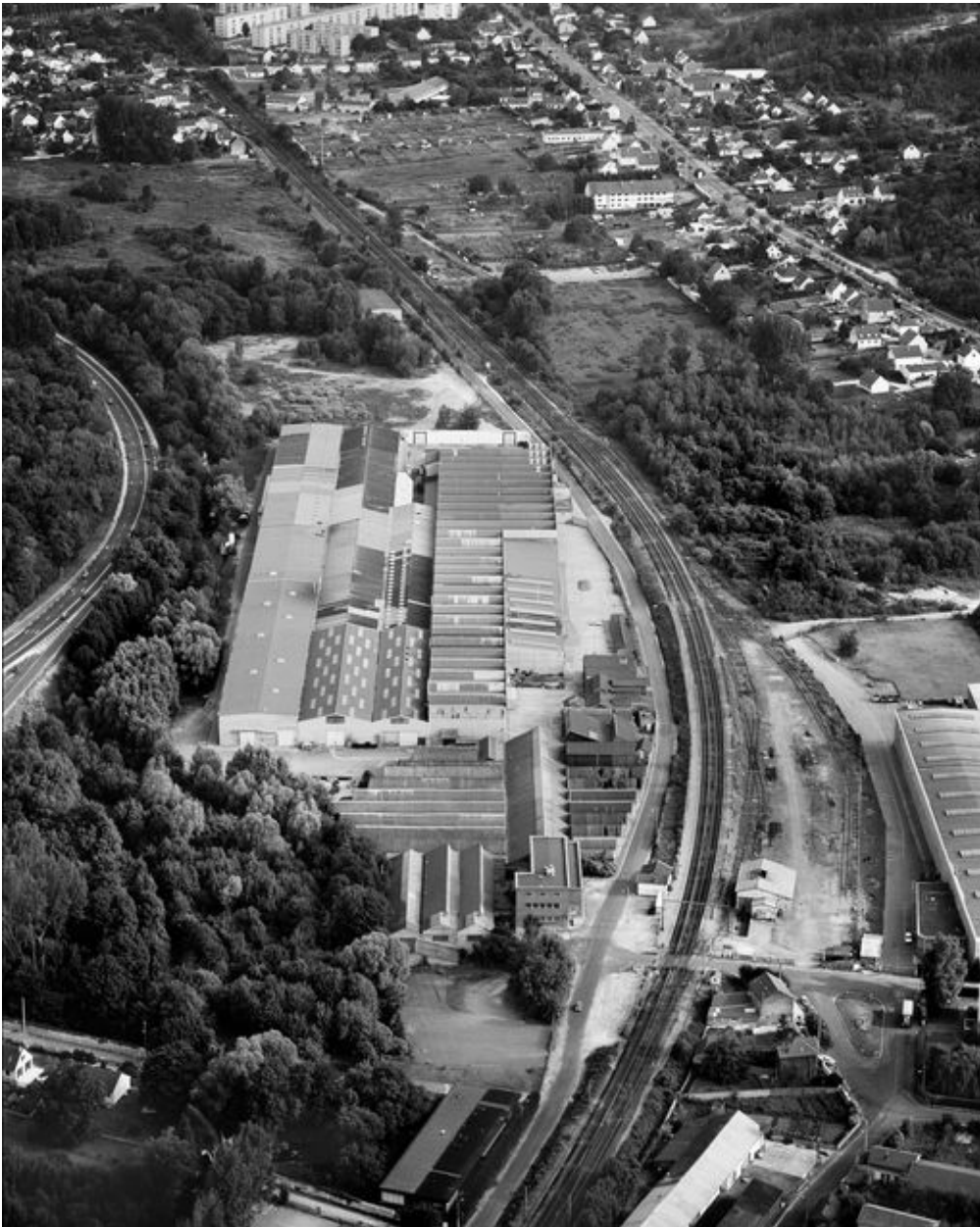
Vue aérienne vers le sud, 1993.
