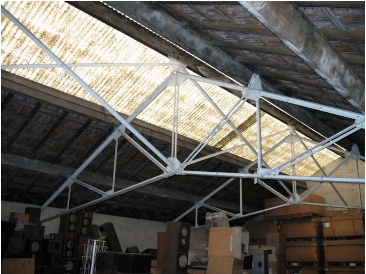
Détail de la charpente métallique apparente dans l'une des mezzanines.
