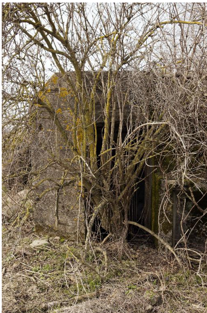
Entrée latérale sud-ouest
