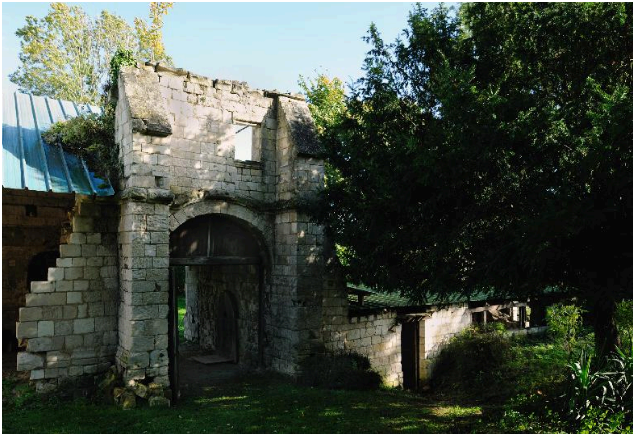
Porterie et ancienne infirmerie, vue intérieure.
