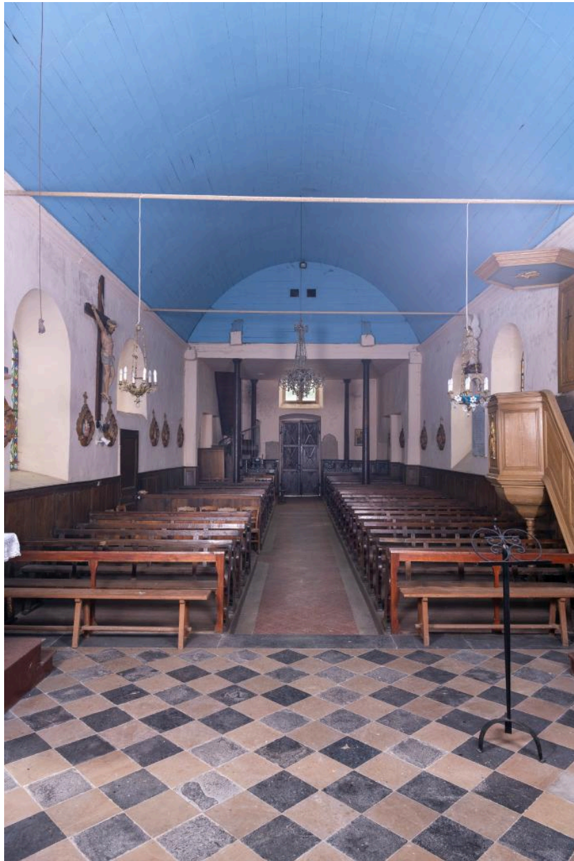
Vue intérieure vers la nef.
