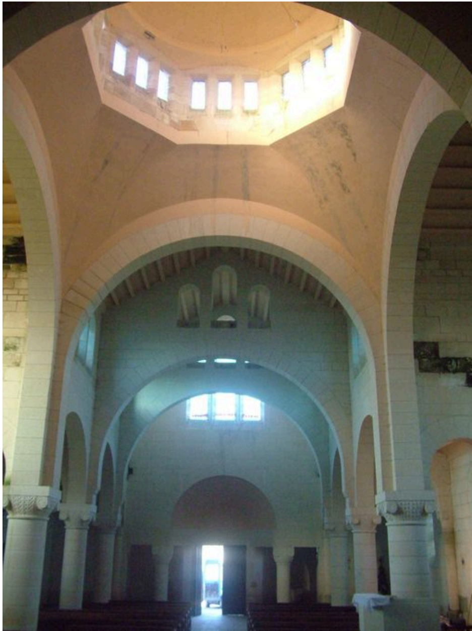
Vue partielle de la coupole et de la charpente.
