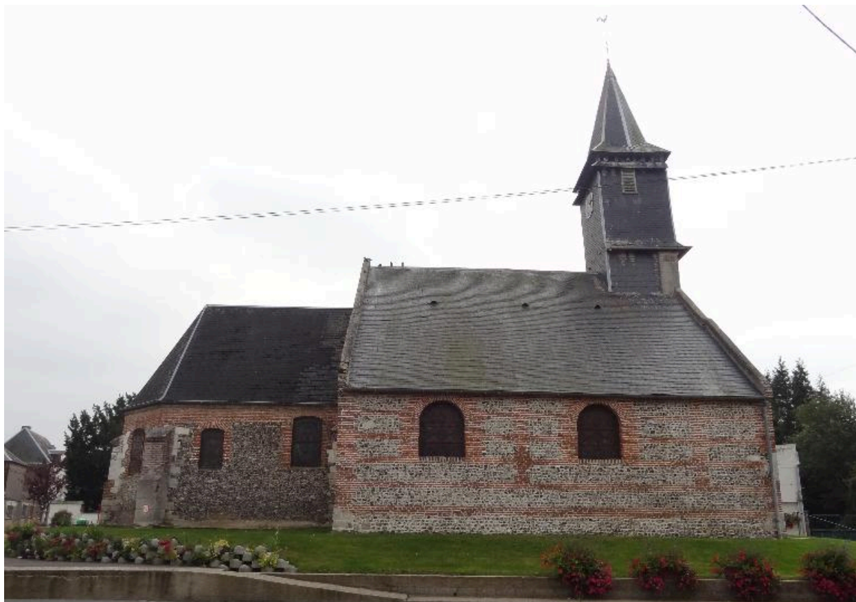
Vue générale depuis la rue Jean-Moulin.
