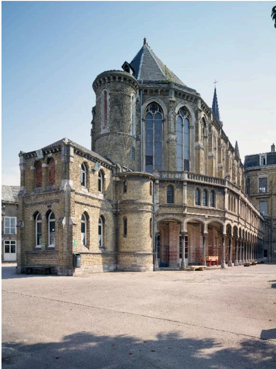
Vue du chevet et de la chapelle haute.
