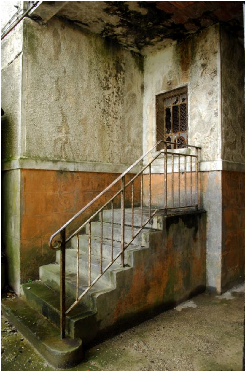
Guichet de paie des ouvriers et des betteraviers aménagé au sud des bureaux.
