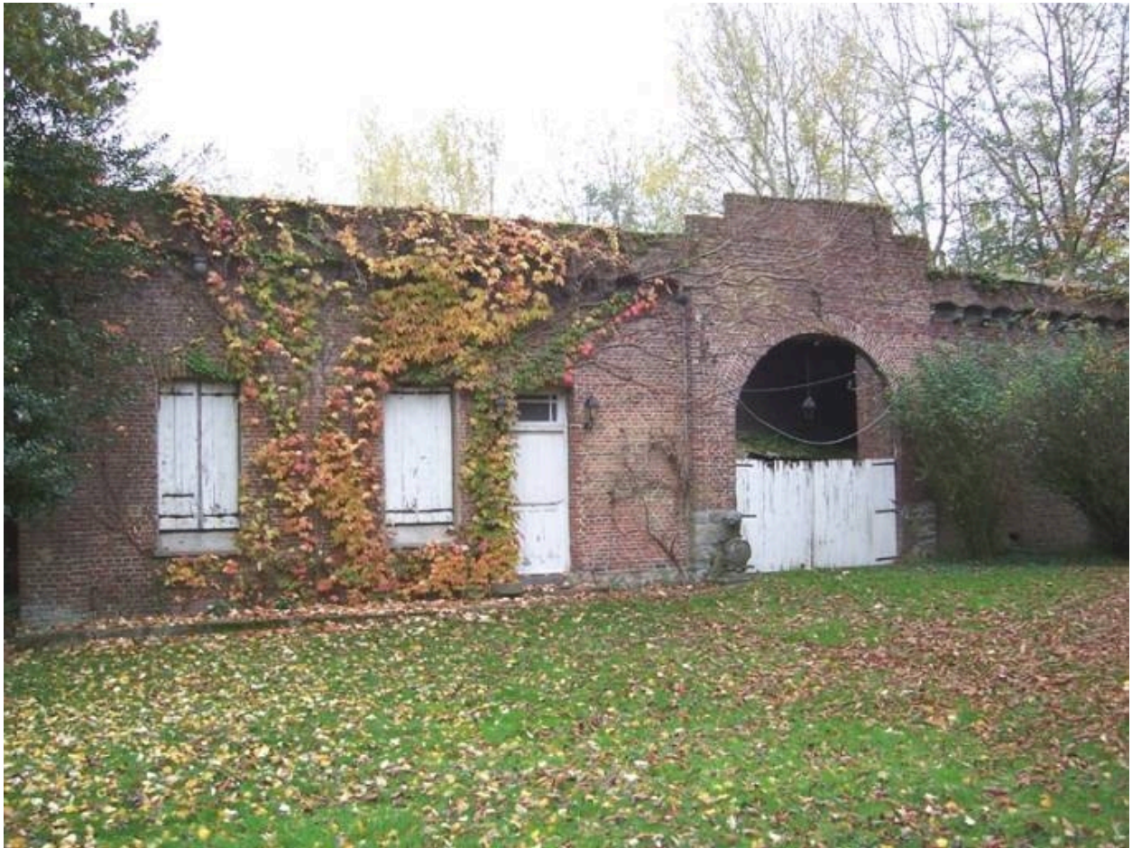
Vue générale des communs.
