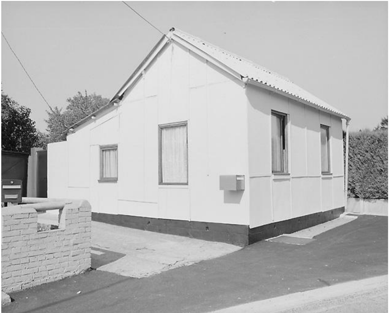
Vue générale de la maison provisoire sise au n°650 de la rue de la Résistance, 2002.
