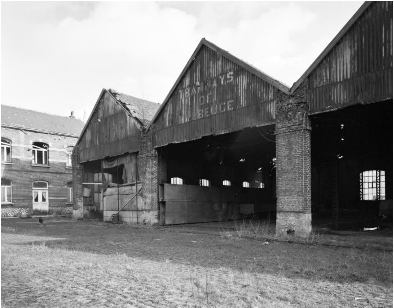
Vue des hangars et de la cour depuis l'entrée.
