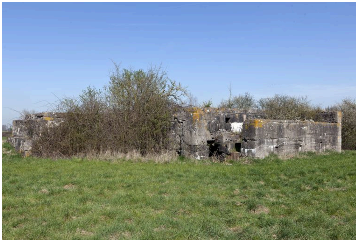
La casemate B. Vue générale vers le nord
