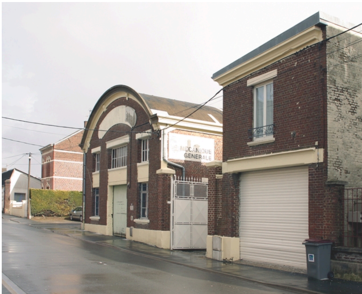
Vue générale du site.
