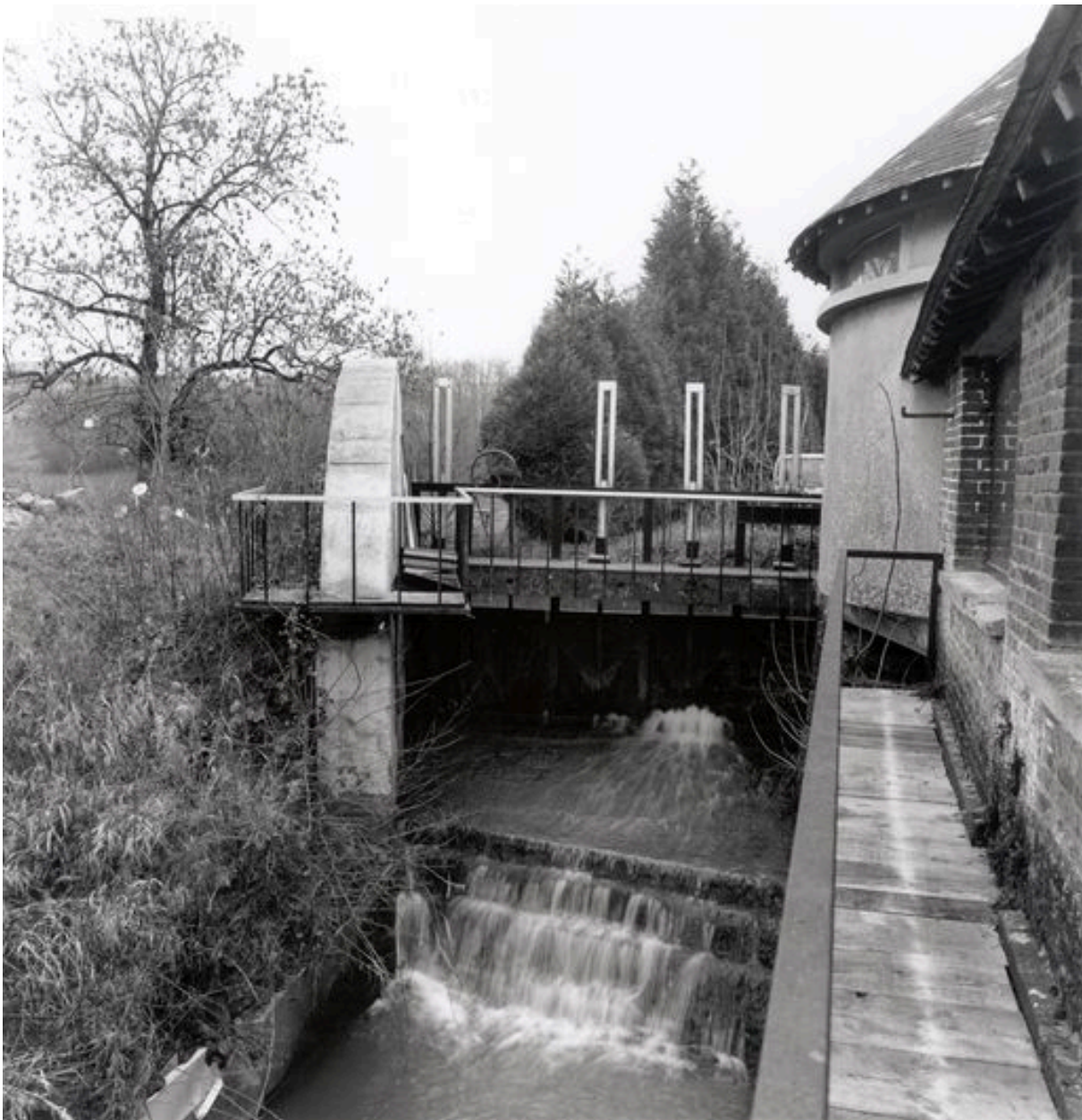
Le vannage de décharge et la chute du moulin.
