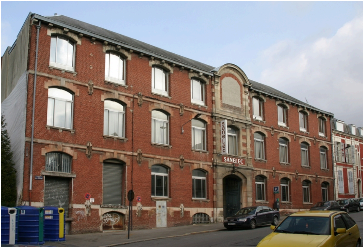
Façade antérieure de la maison de commerce.
