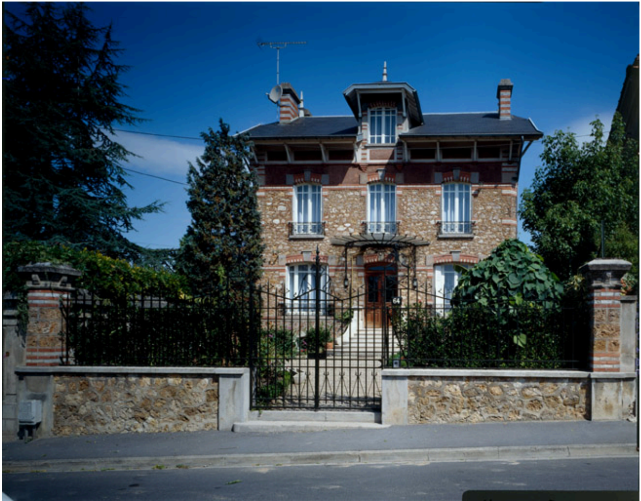
Vue d'ensemble depuis la rue.
