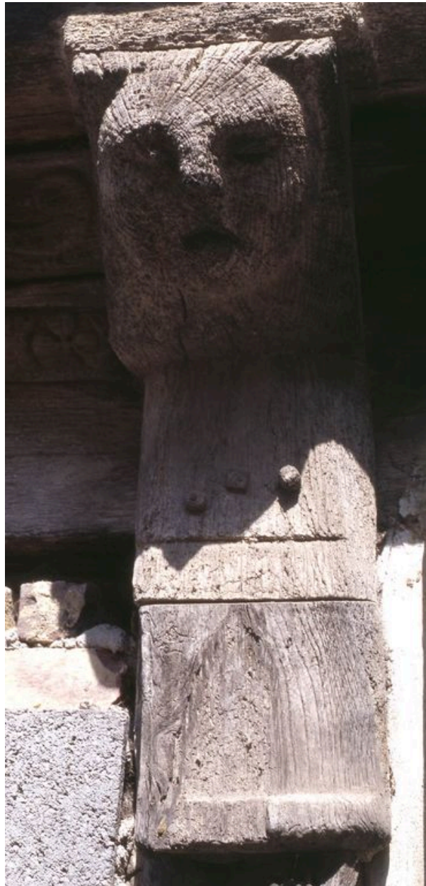
Détail d'une console sculptée, maison Landot, élévation postérieure sur cour.
