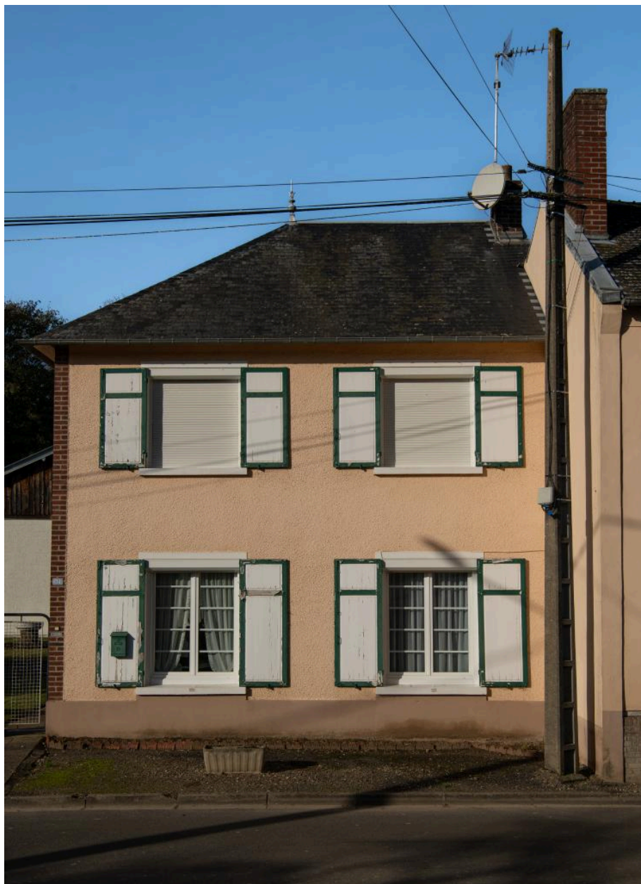
Maison reconstruite après les bombardements de 1940 (?), n°51 Grande Rue, vue depuis l'est.
