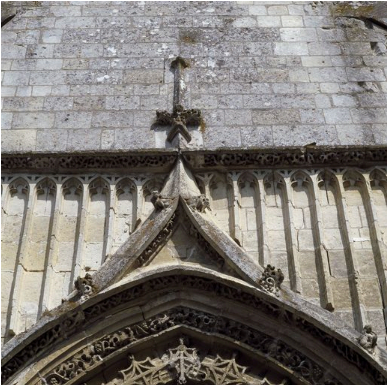
Détail de la façade occidentale.
