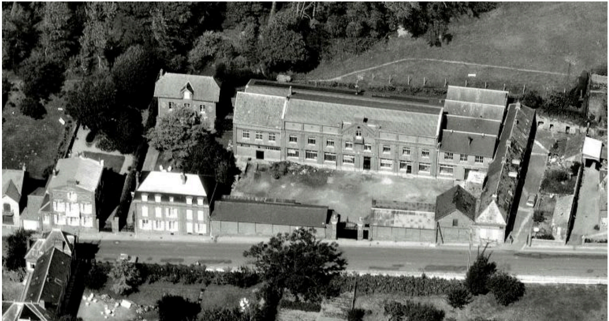
Vue de l'ancienne usine, en 1988.
