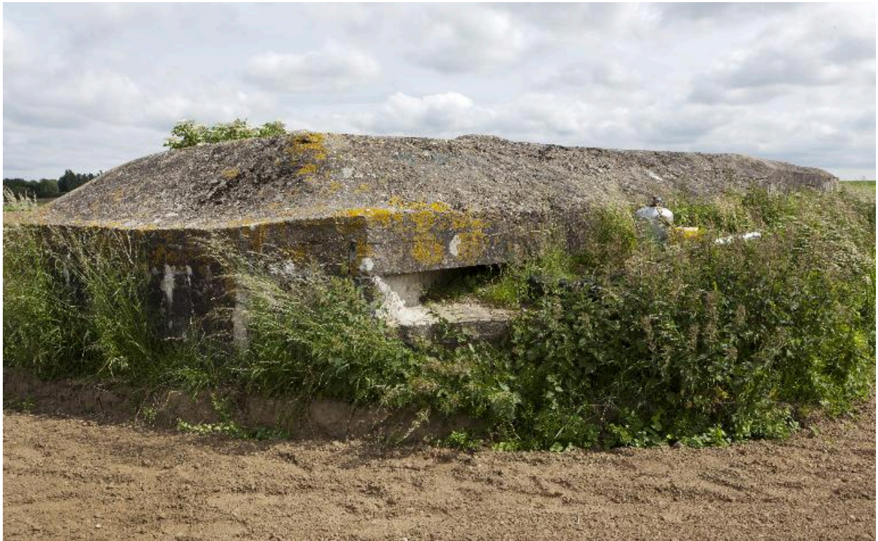
Créneau de fustillade, vers le sud
