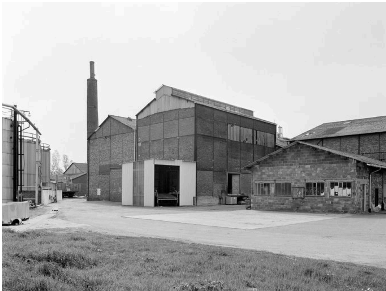
La chaufferie, pignon sud.
