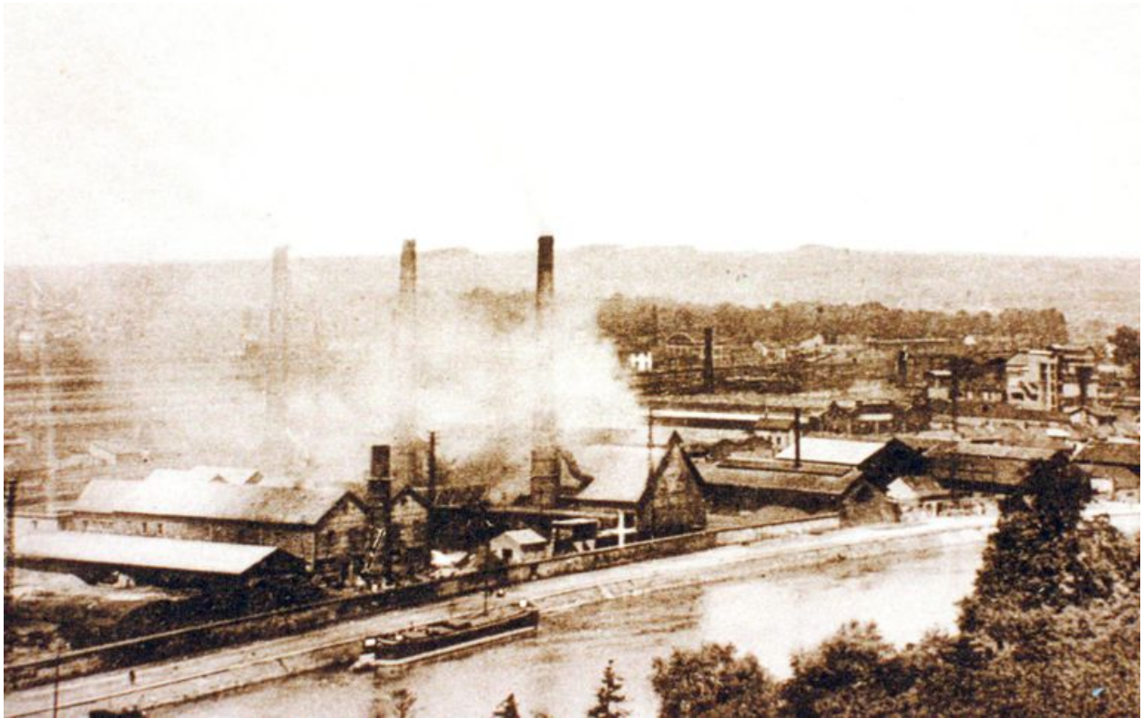
Vue générale de l'usine de la Vieille-Montagne.
