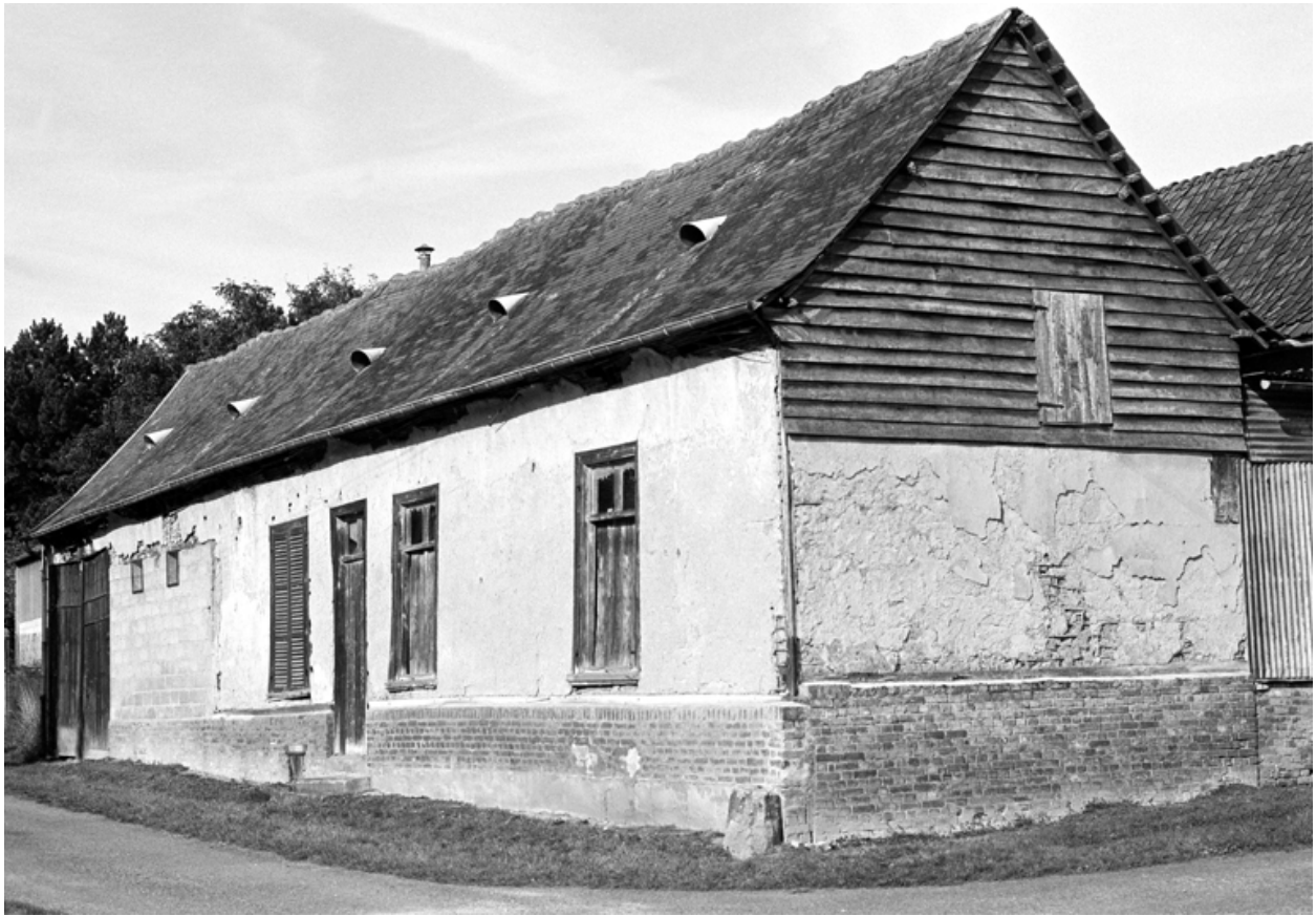
Ancien logis en torchis ouvrant sur la place de l'Eglise.
