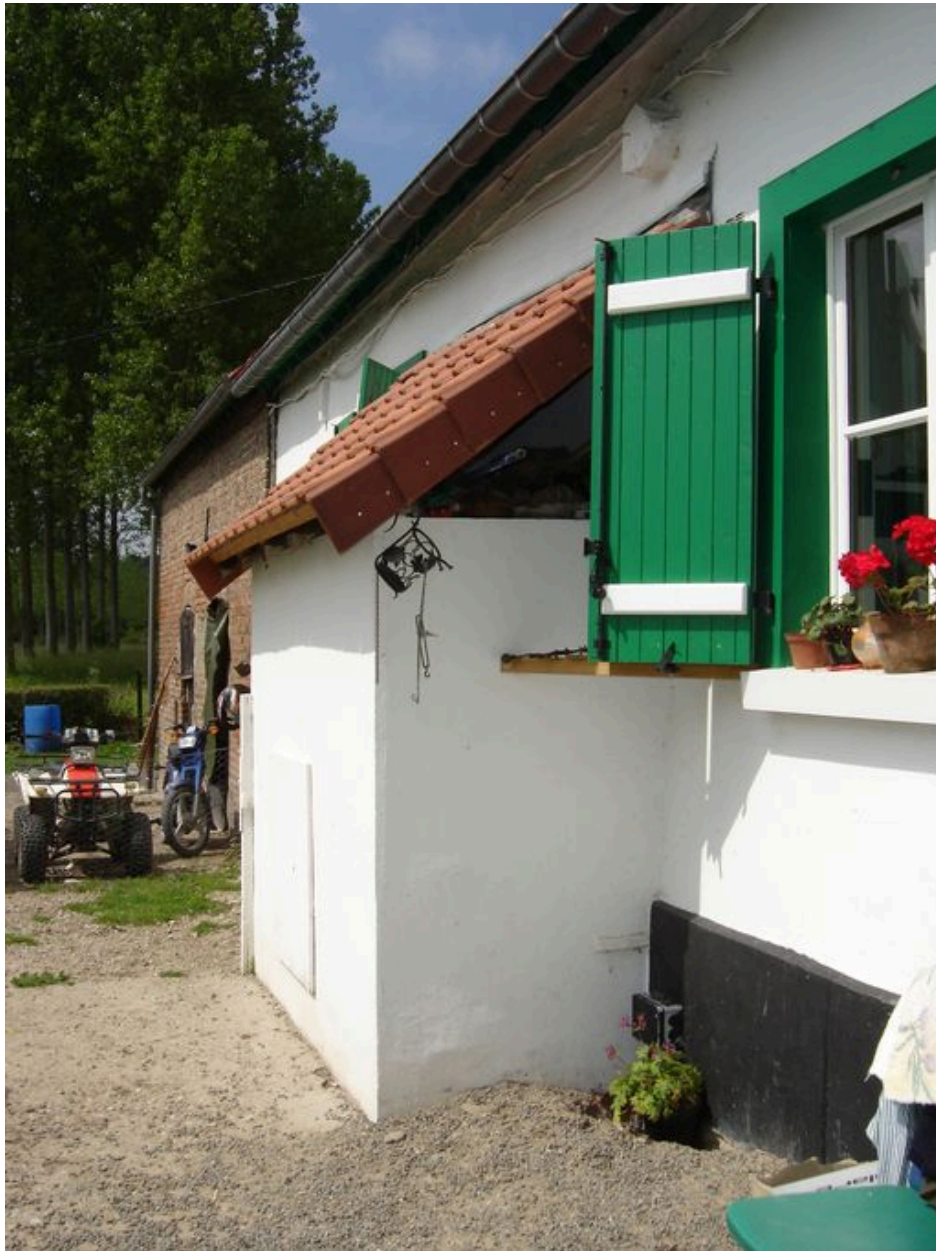
Vue postérieure du logis avec l'excroissance contenant le four à pain.
