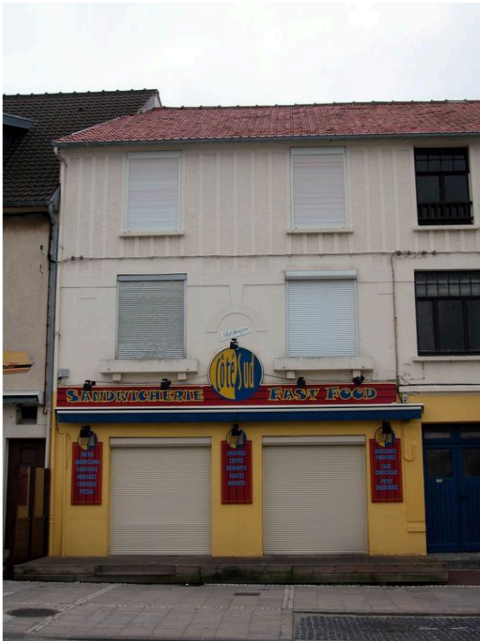
Détail de travées sur l'avenue de la Plage.
