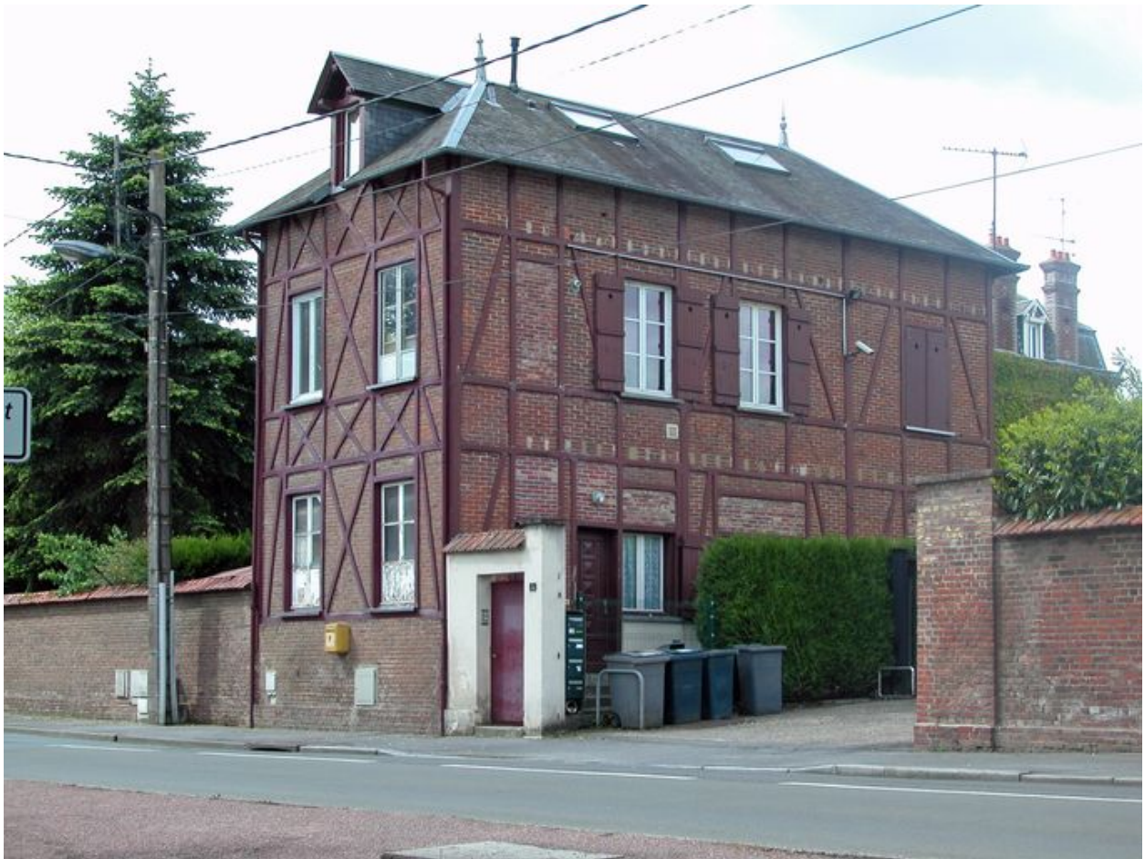
Vue latérale des bureaux.
