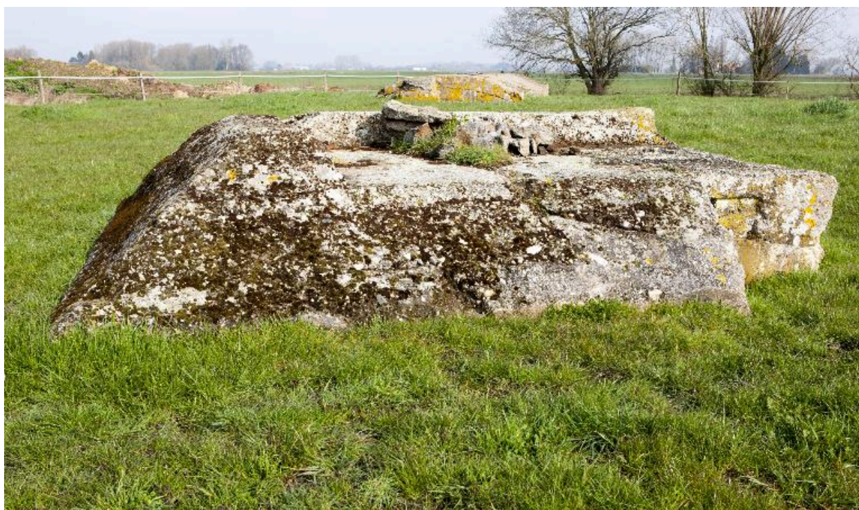
Casemate sud, vers le nord-ouest
