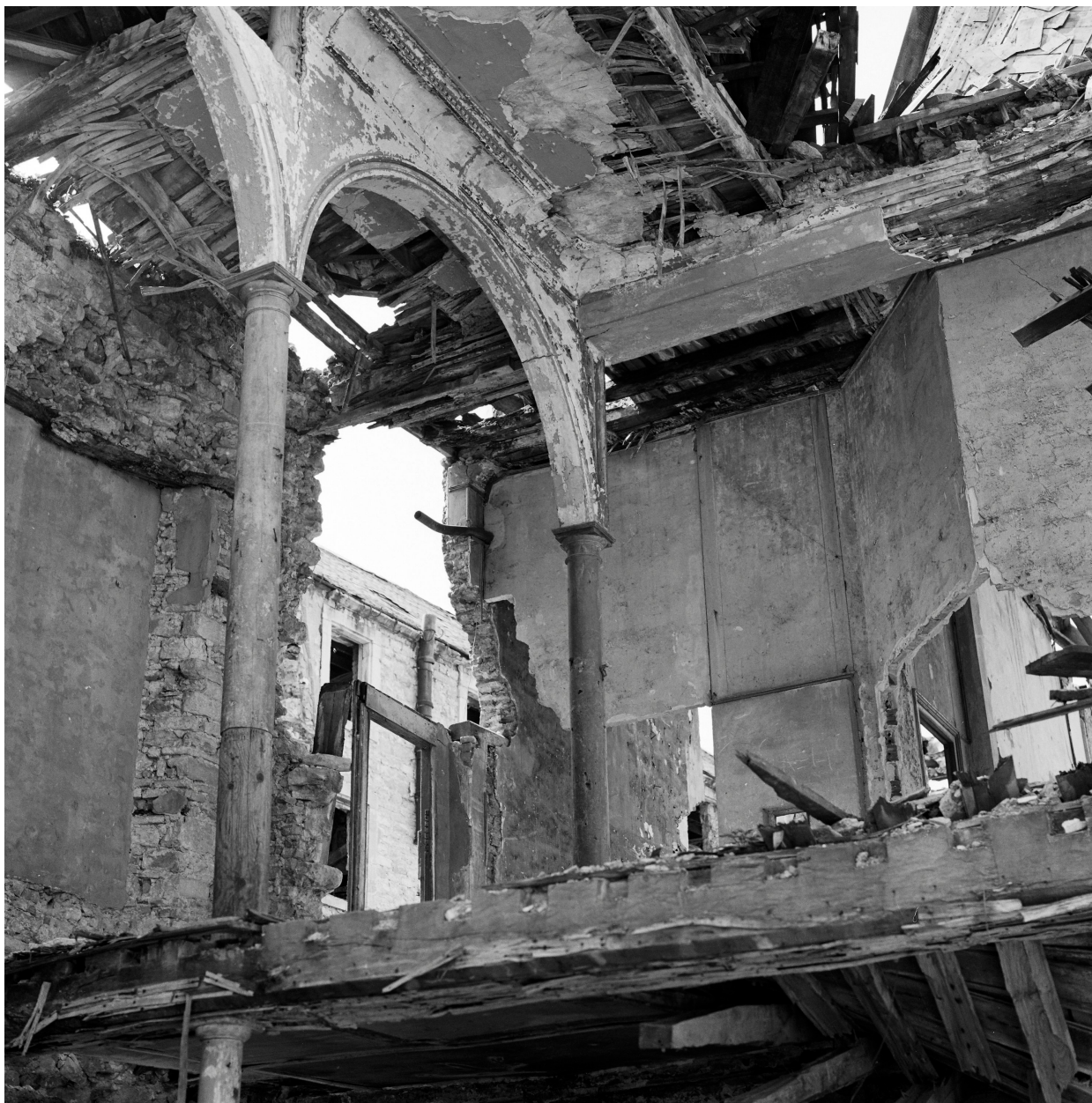
Bâtiment F, salle des fêtes, vue intérieure vers dégagement.
