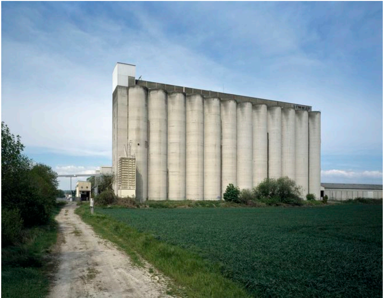
Vue générale des silos de la SEMMAP.
