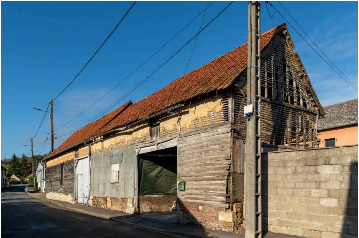
Deux granges sur rue d'anciennes fermes avec logis en fond de cour, n°6 et 4 rue de Lavacquerie, vue depuis le sud-est.
