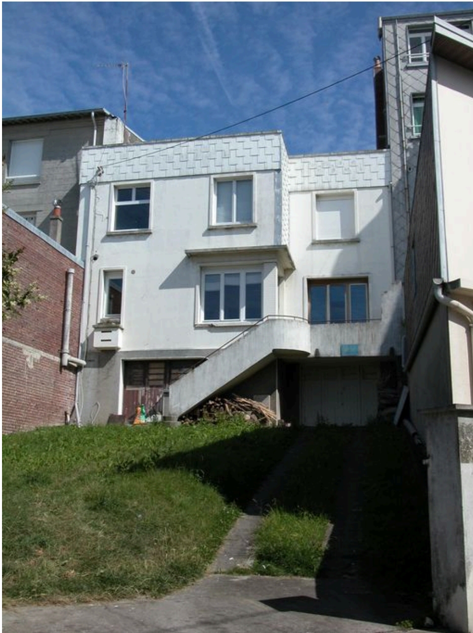
Façade postérieure, vue depuis la rue de la Plaine.
