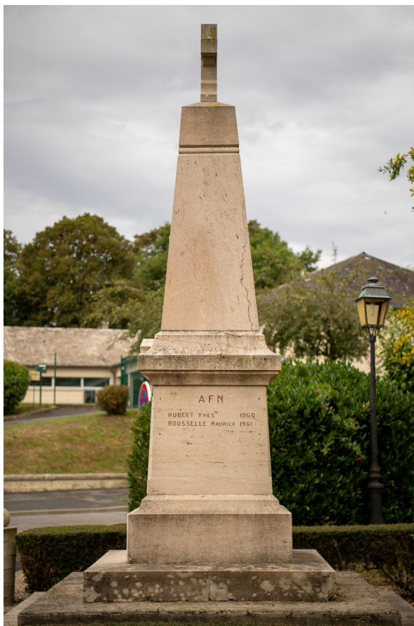
Vue générale depuis l'est
