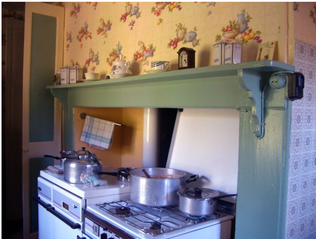
Vue d'une cheminée traditionnelle avec tablette supportée par deux corbeaux sculptés ; aménagement moderne pour la cuisine.
