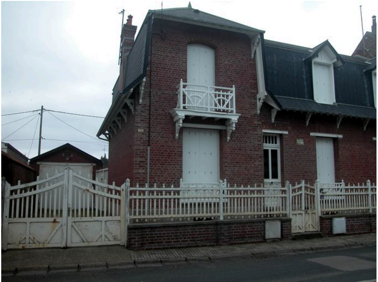
Détail du garage isolé en fond de parcelle.
