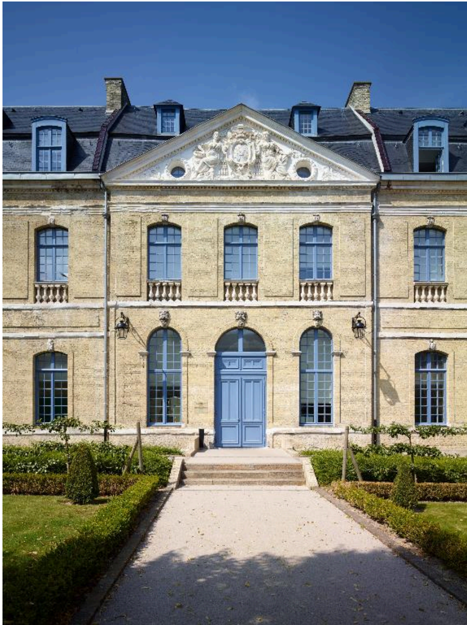
Bâtiment nord, élévation de la façade sud donnant sur la cour d'honneur, détail de l'avant-corps central.
