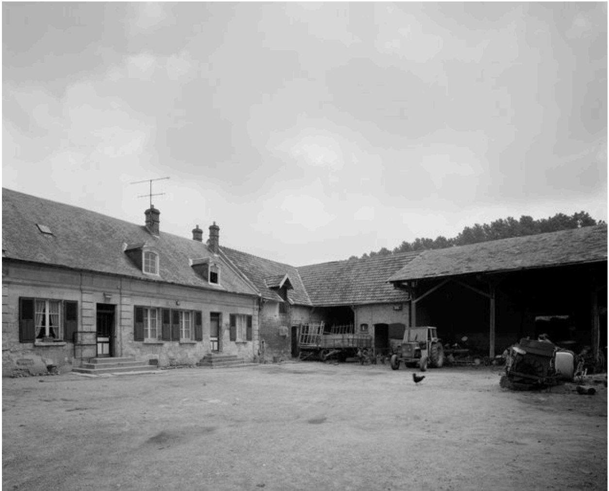
Bâtiments sur cour.
