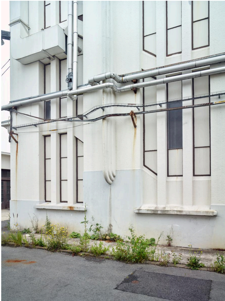
Base du pignon ouest de l'atelier de fabrication (G). Détail des baies éclairant l'escalier et moulures toriques décoratives.
