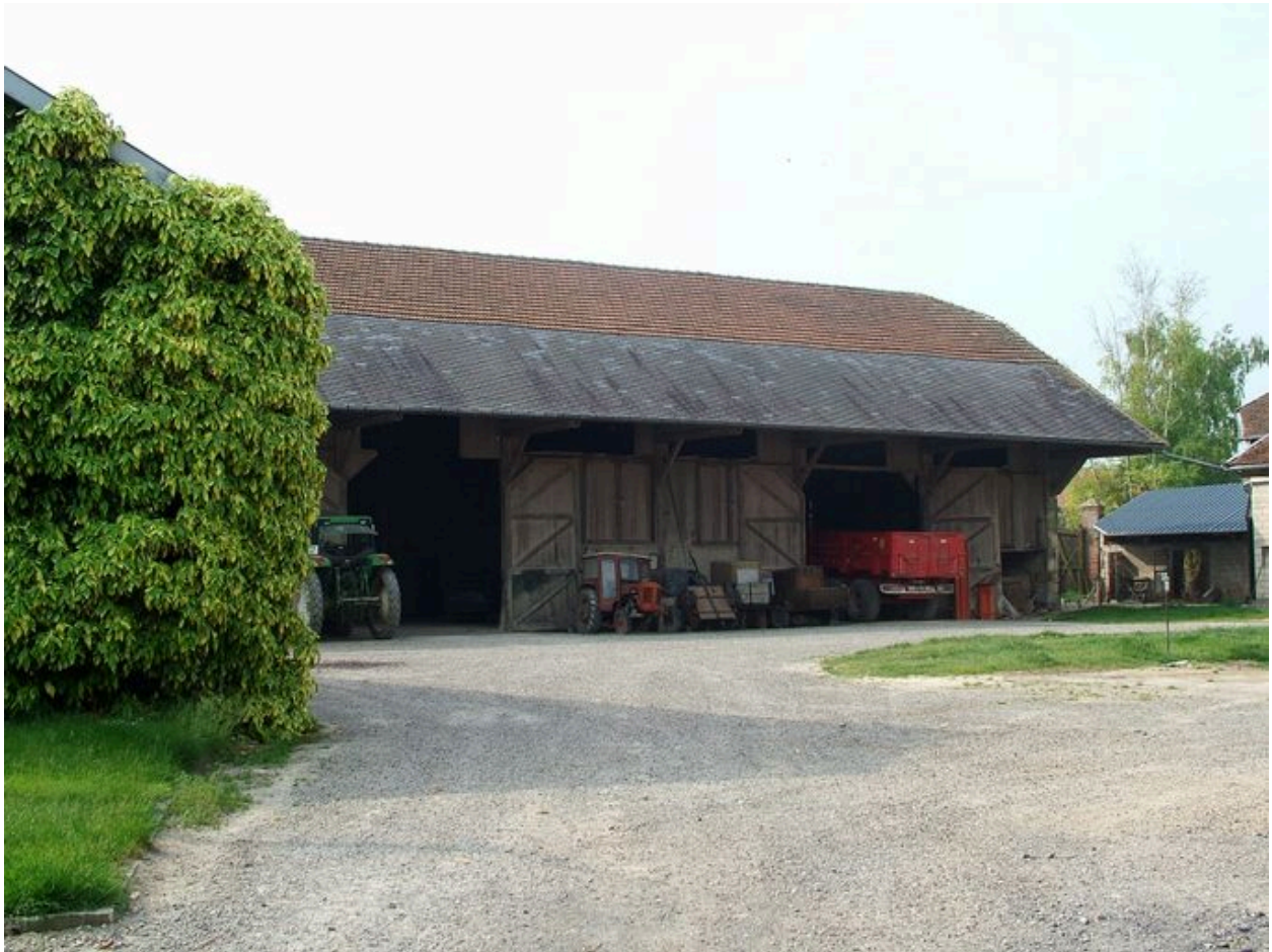
Vue de la grange.
