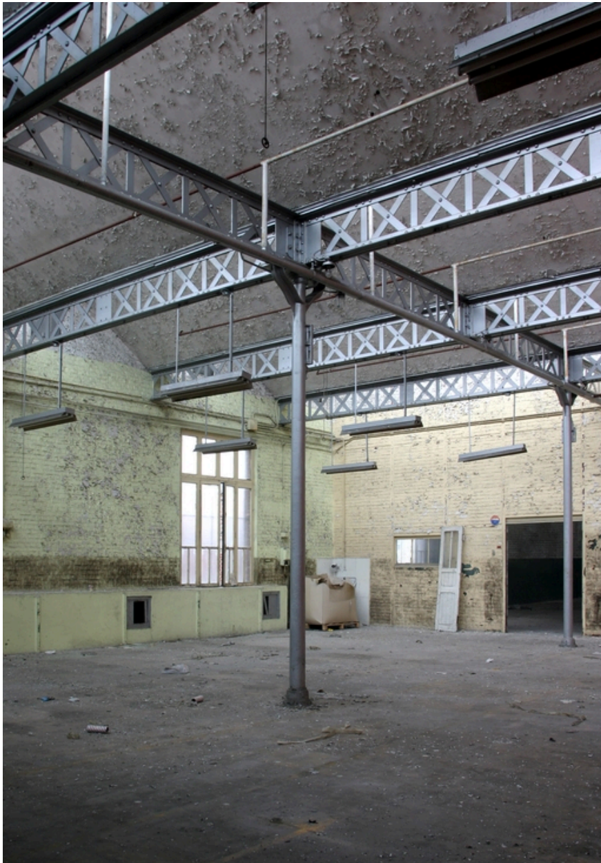
Vue intérieure des entrepôts de produits manufacturés.
