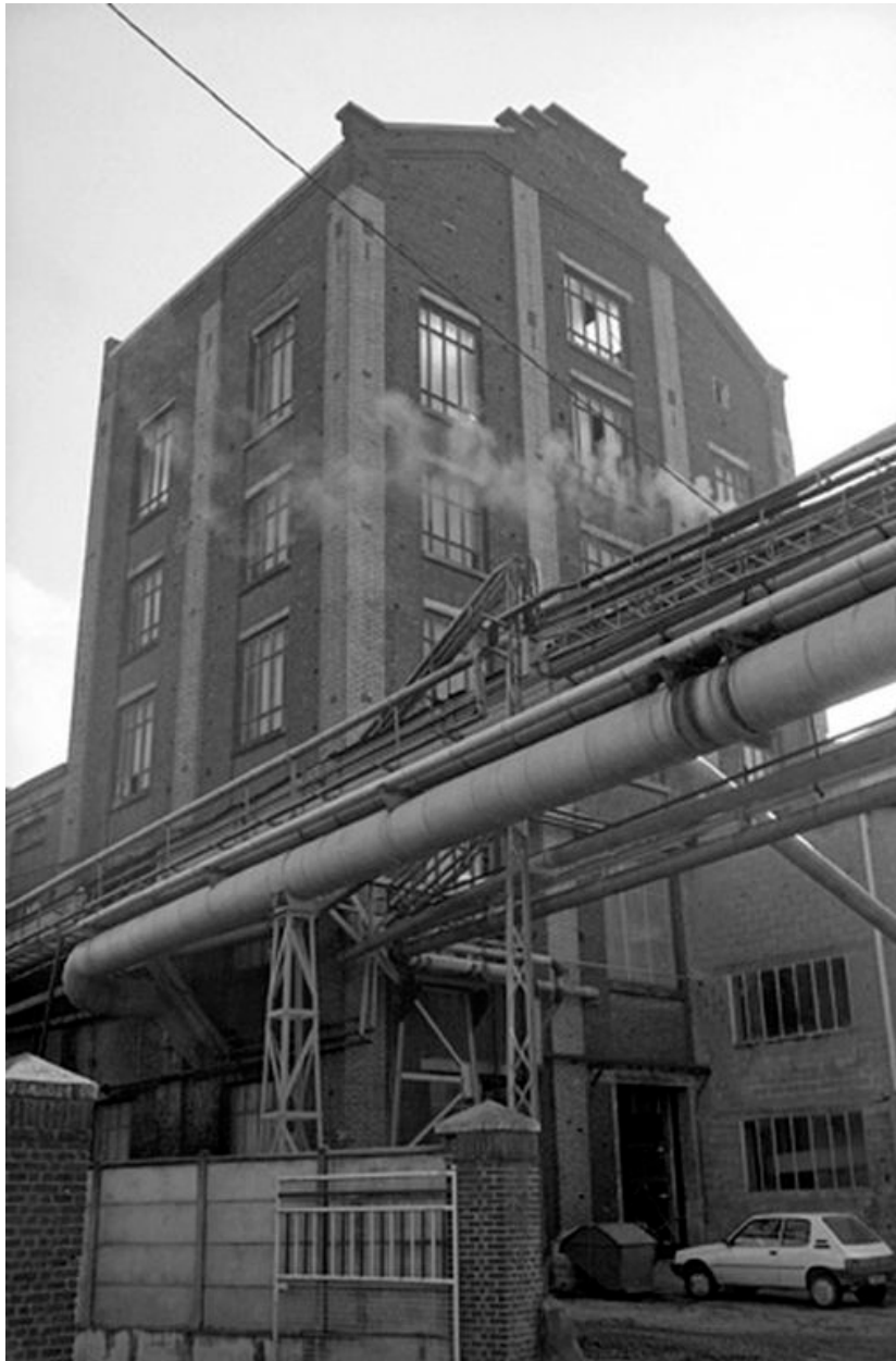
Atelier de fabrication, flanc ouest.
