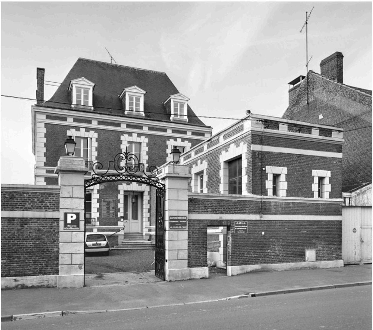
Vue du portail et des façades sur cour, depuis la rue.
