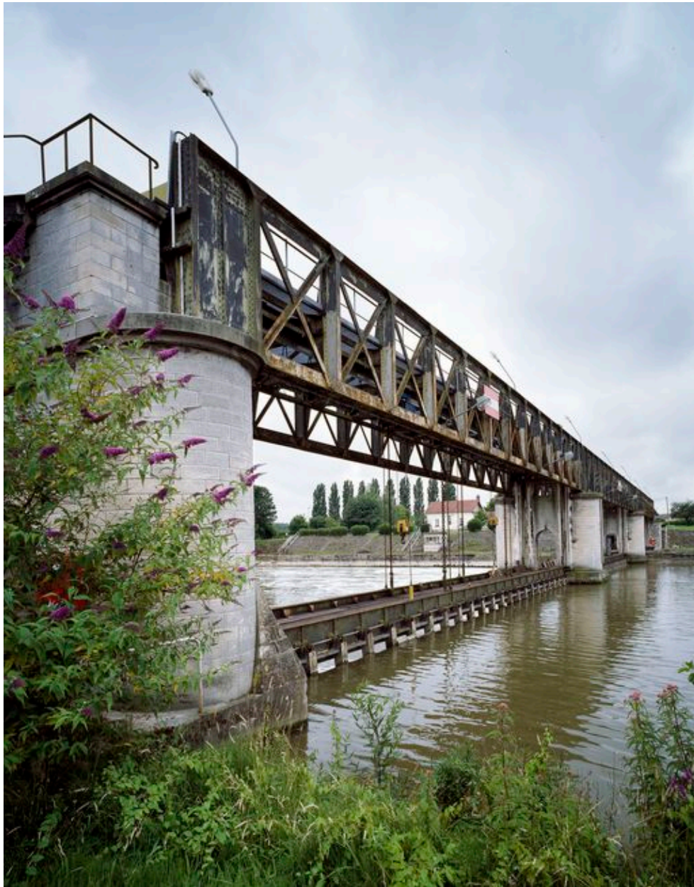
Sarron : détail du barrage Derôme.
