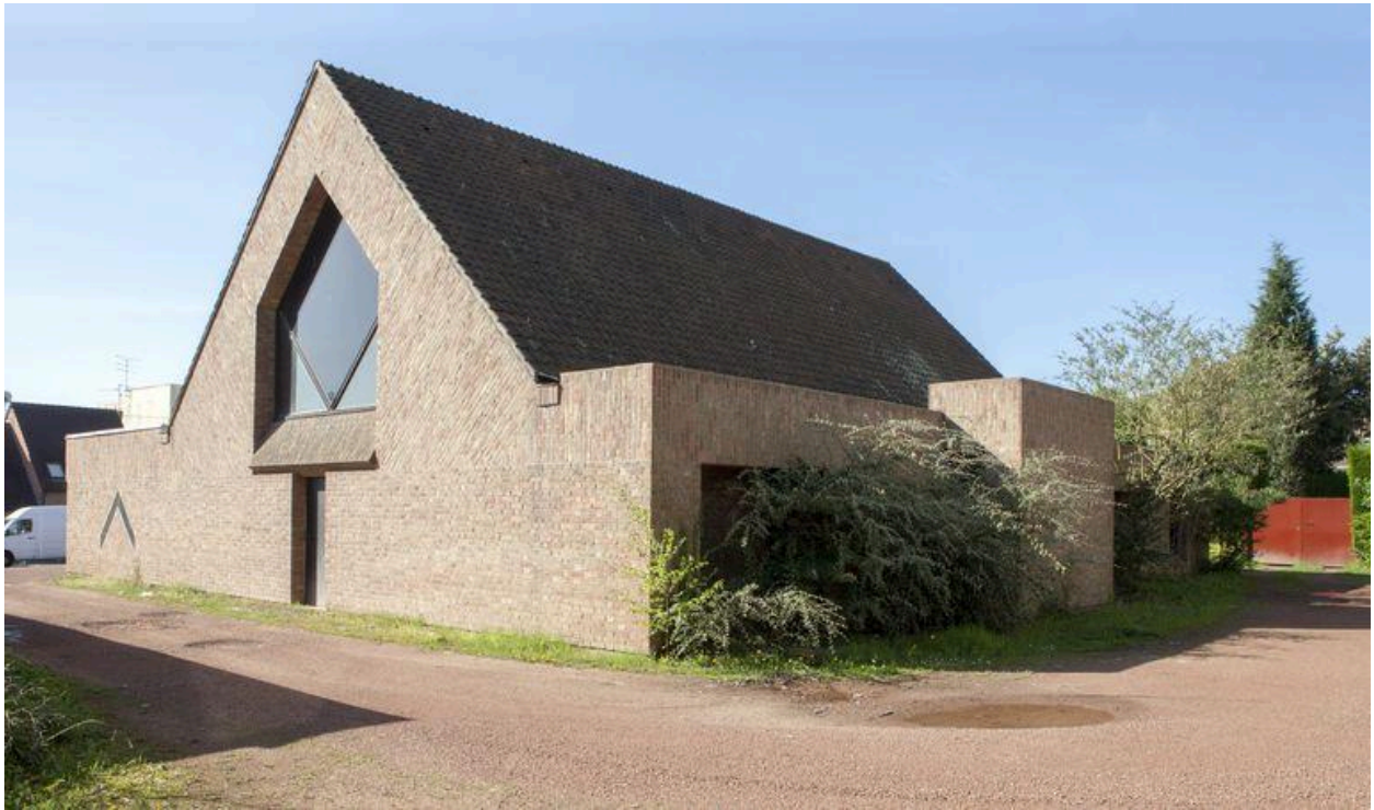
Élévation postérieure de l'église et flanc droit.
