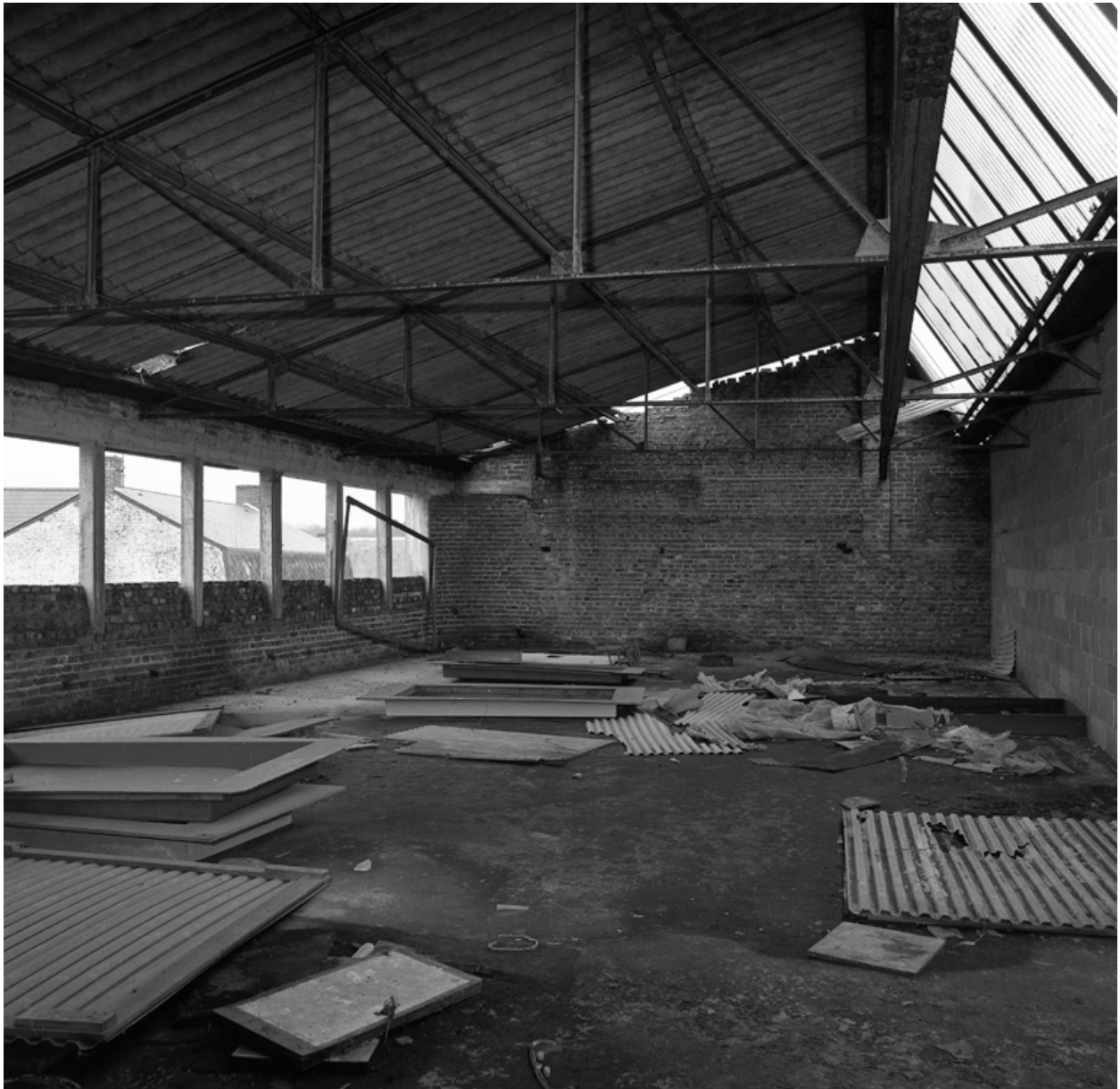
Vue intérieure des anciens ateliers de fabrication.
