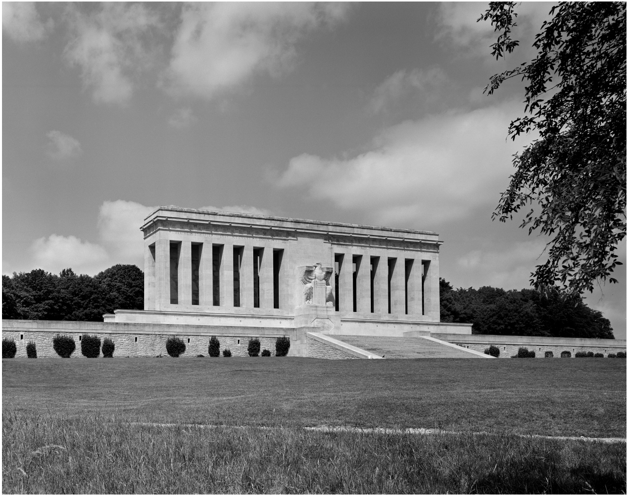
Vue d'ensemble de la face sud.
